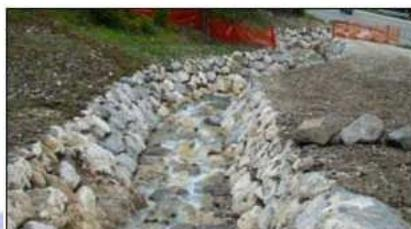
FOTO INTERVENTO TIPO - Realizzazione di massicciate con massi addossati in corrispondenza dell'argine sinistro e destro del fosso
