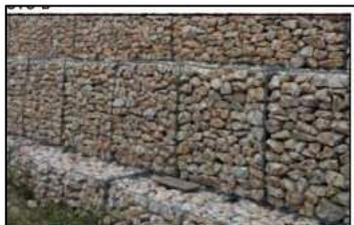
FOTO INTERVENTO TIPO - Realizzazione di gabbionate in corrispondenza dell'argine sinistro del fosso. I gabbioni hanno dimensione 1m x 1m e sono realizzati con rete metallica e pietrame.
