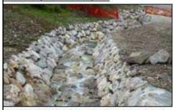
FOTO INTERVENTO TIPO - Realizzazione di massicciate con massi sfossati in corrispondenza dell'argine destro del fosso.
