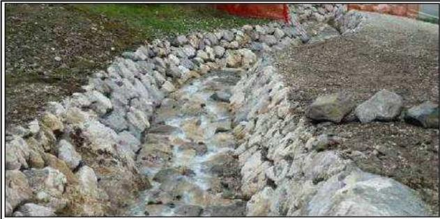
**FOTO INTERVENTO TIPO** - Realizzazione di massicciate con massi addossati in corrispondenza degli argini destro e sinistro del fosso.
