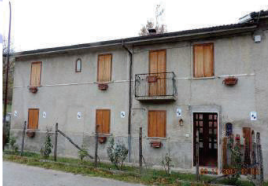
FOTO C - PROSPETTO FRONTALE APPARTAMENTO 1
