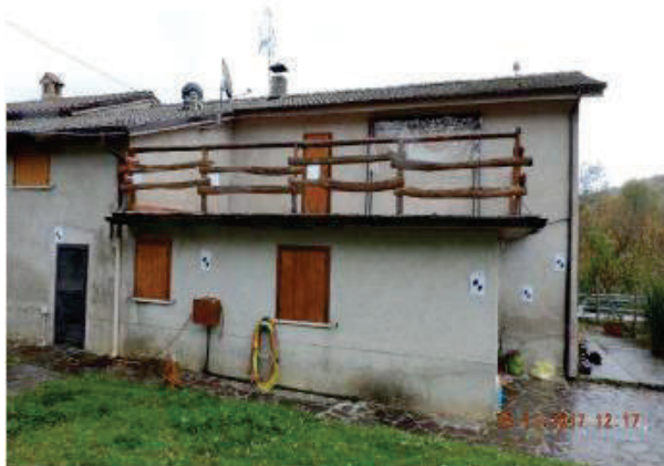
FOTO F - PROSPETTO POSTERIORE APPARTAMENTO 1
