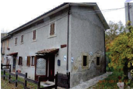
FOTO A - PROSPETTO D'ANGOLO FRONTE - LATO DESTRO
