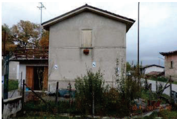
FOTO E - PROSPETTO LATO SINISTRO APPARTAMENTO 1
