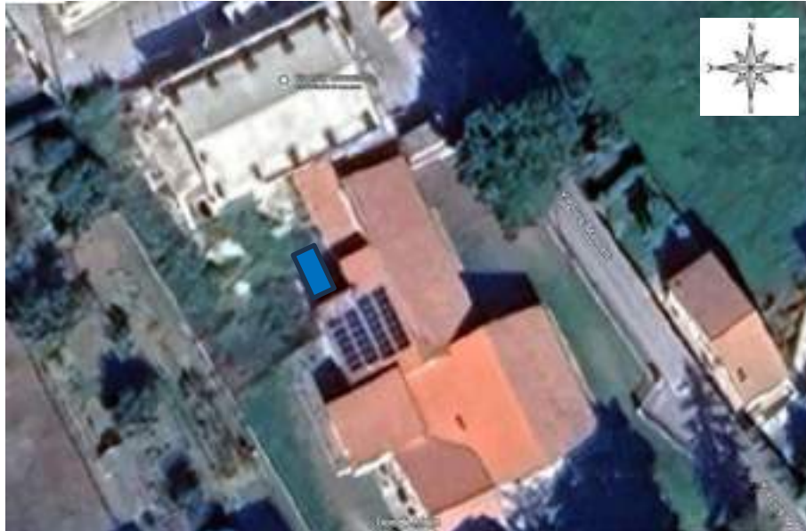
Figura 3-Posizione del serbatoio (in blu) rispetto alla palestra e alla scuola
