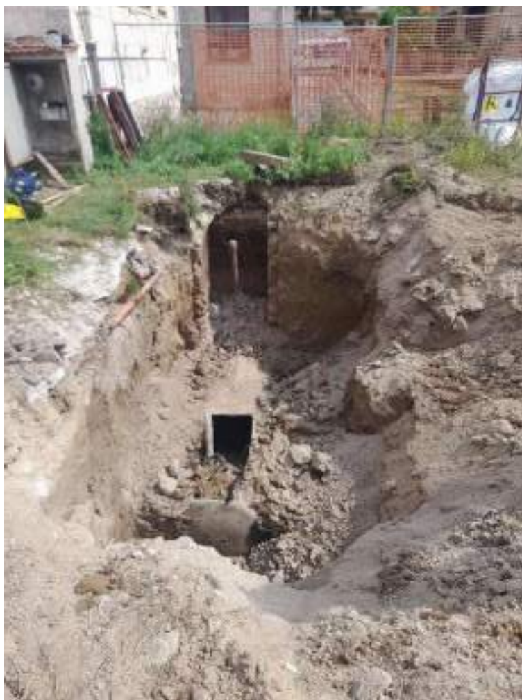
Figura 7- Foto dello scavo al momento del rinvenimento del serbatoio
