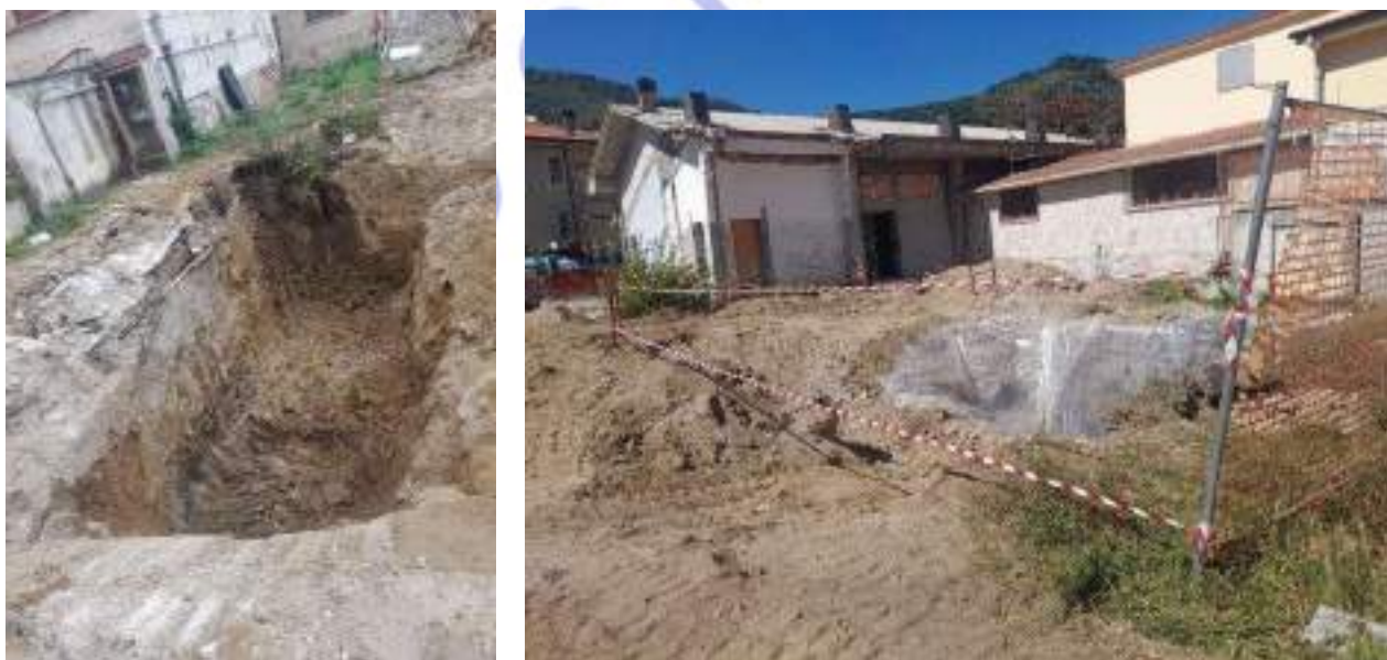
Figura 8- Foto dello scavo realizzato
