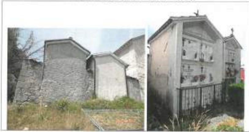
CIMITERO DI PRATO E CASCELLO – CAPPELLA 16 E 17
