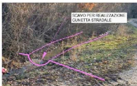
*Per il tratto 1A è prevista la realizzazione di nuove cunette stradali in cemento vibrato a sezione trapezoidale, al fine di consentire lo scolo delle acque meteoriche. È necessario verificare le livellette delle pendenze prima di procedere con la realizzazione dell'intervento.*
