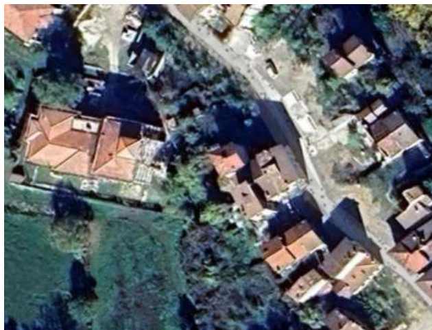
Foto aerea post demolizione
