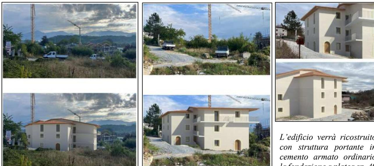
*L'edificio verrà ricostruito con struttura portante in cemento armato ordinario la fondazione a platea sp. 40*
