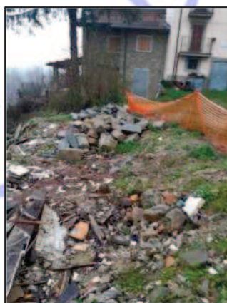
Foto post sisma post demolizione
