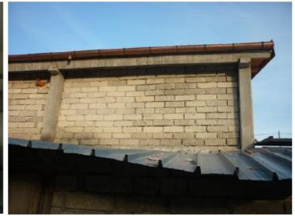
Foto 4: Prospetto OVEST dettaglio
