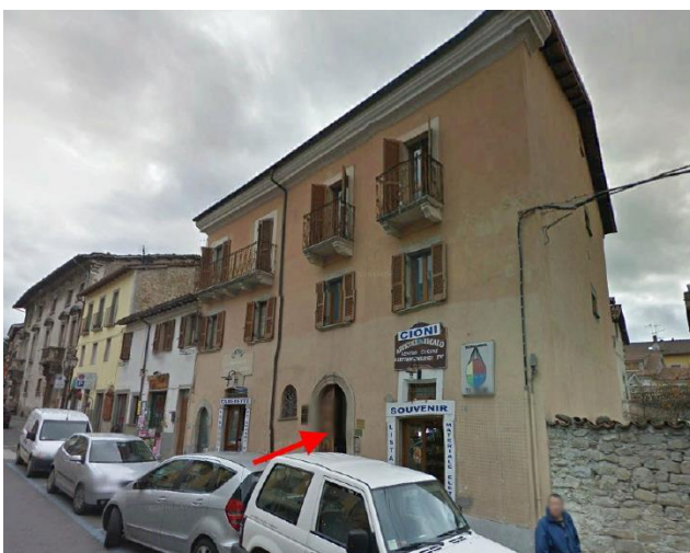
Vista esterna del fabbricato prima del sisma
