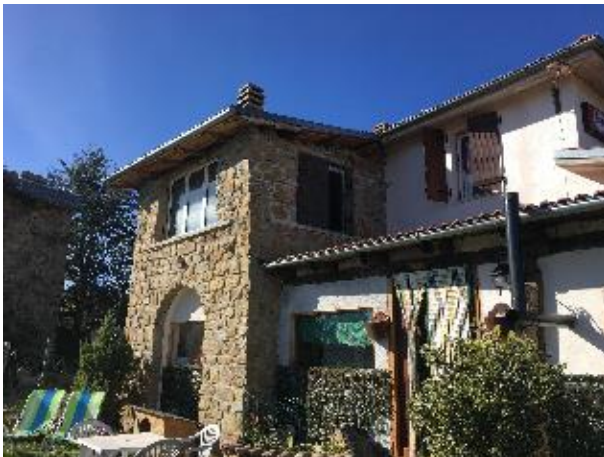
Vista esterna edificio danneggiato
