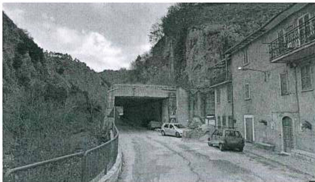
Comune di Posta – Sigillo – Galleria paramassi
