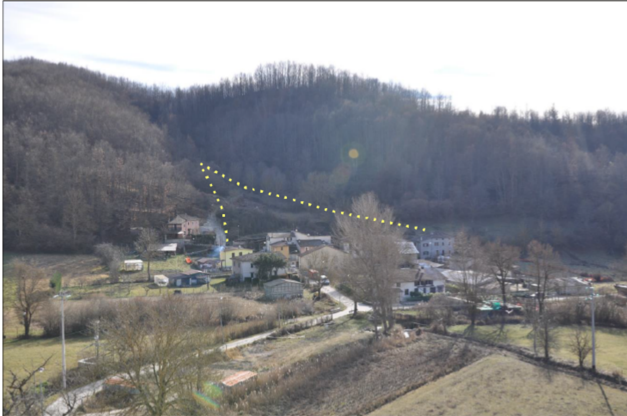
VEDUTA DI BRICCA CON CONO DI DETRITO
