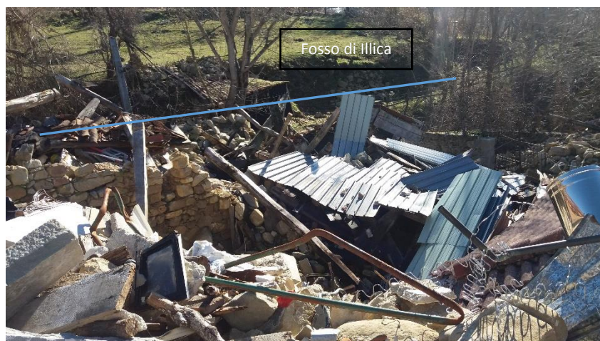
Foto 5 Fosso di Illica e abitazioni sull'argine
