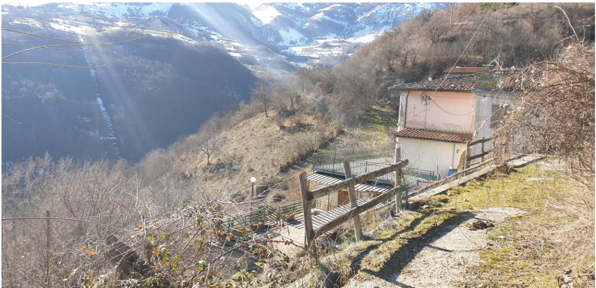
Area di intervento con vista in direzione W
