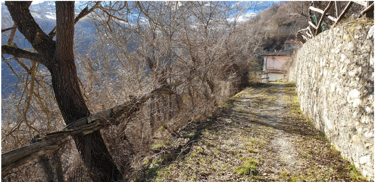
Area di intervento con vista in direzione SW
