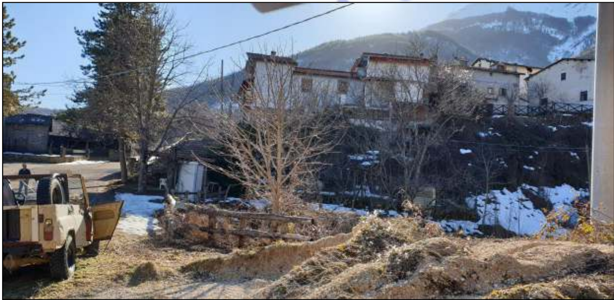
Vista frontale della zona di intervento in direzione S
