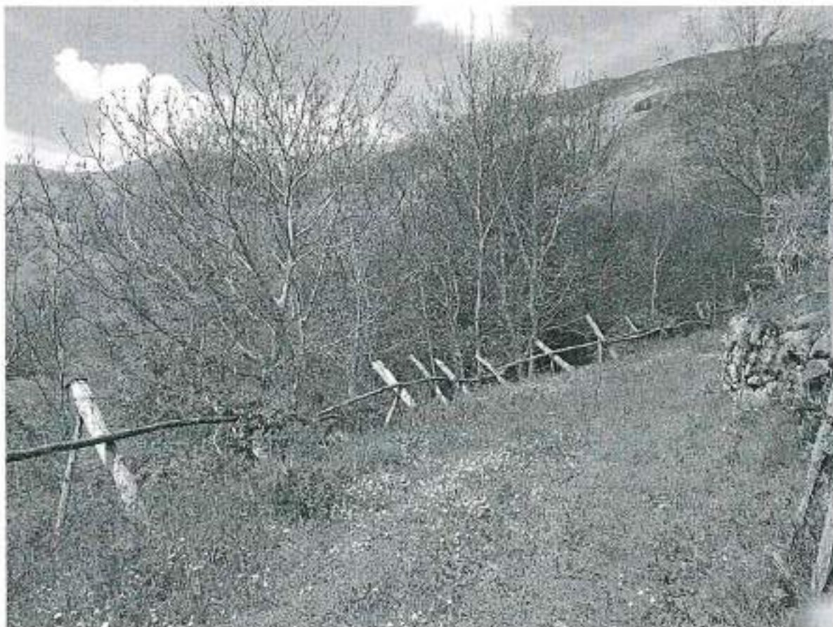
Foto 5: Cedimenti interni all'abitato
