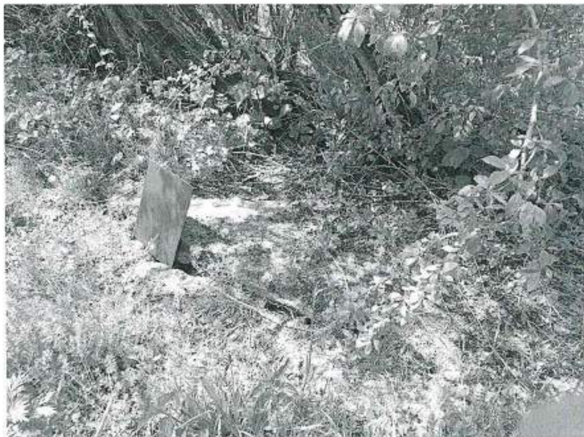
Foto 4: Cedimenti interni all'abitato
