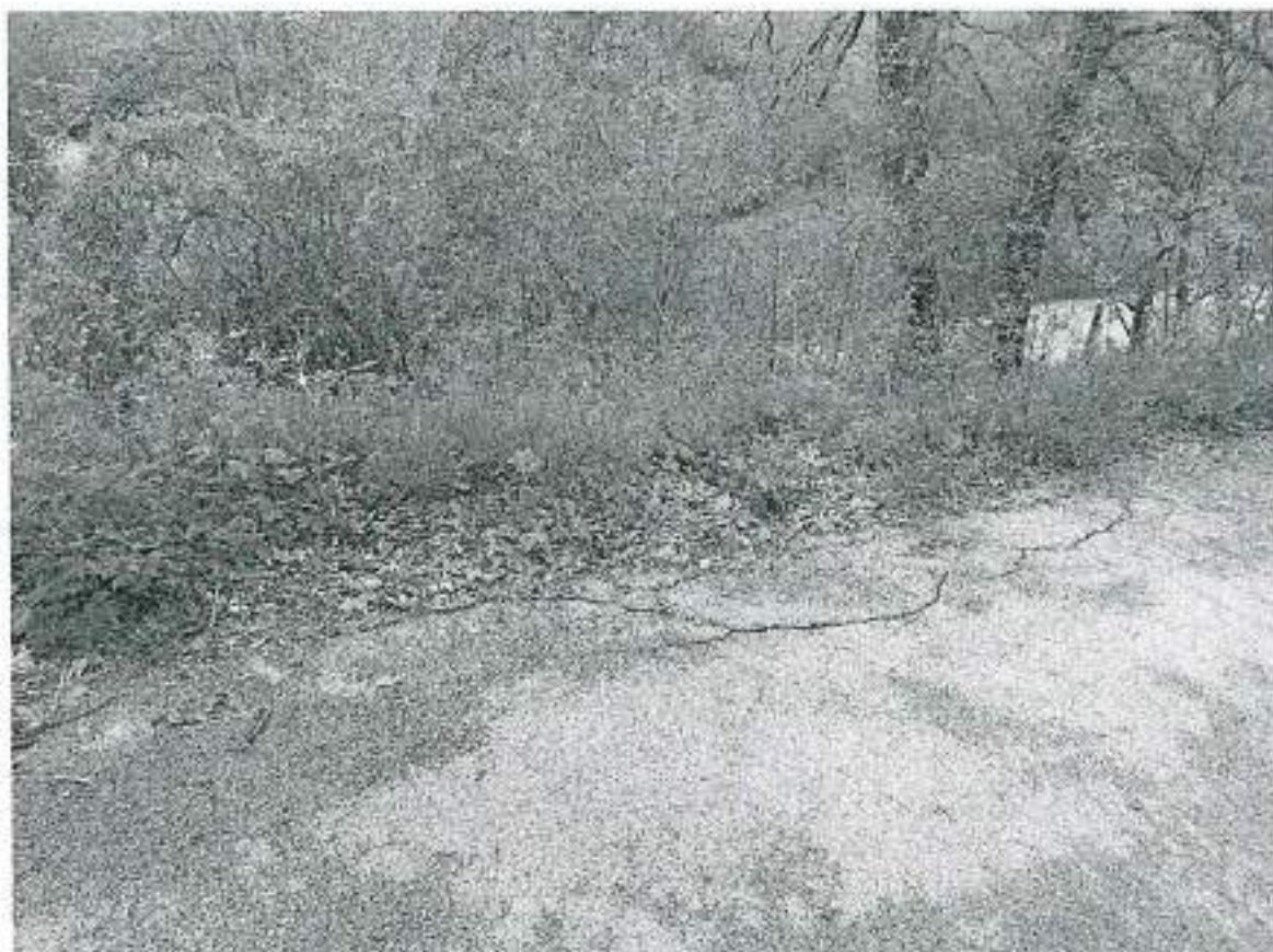
Foto 1: Cedimenti interni all'abitato
