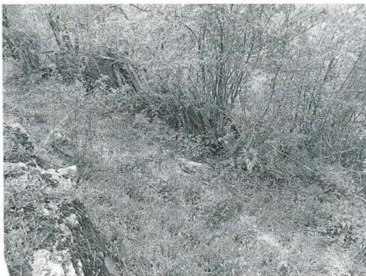
Foto 2: Cedimenti interni all'abitato
