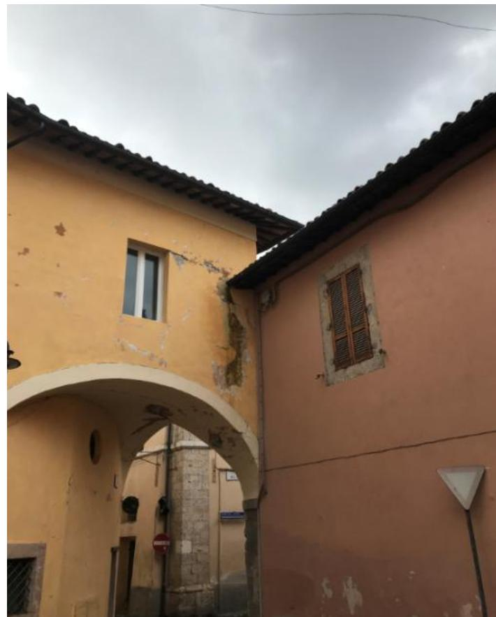
Effetti dell'interazione tra U.S. dovuto a “soluzioni di continuità costruttive” che determinano giunti inefficaci, ad irregolarità plano-altimetriche e alla spinta di archi e volte non contrastate.
